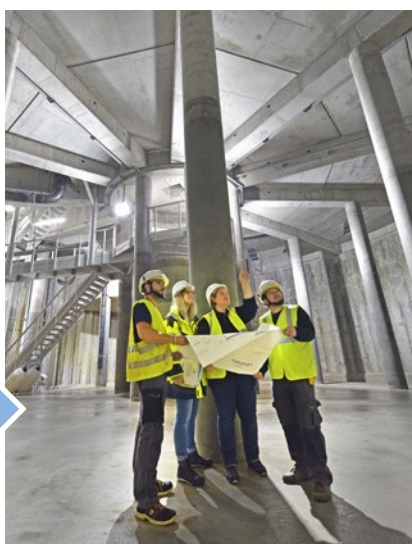
Bassin de stockage-restitution des Vergnes
