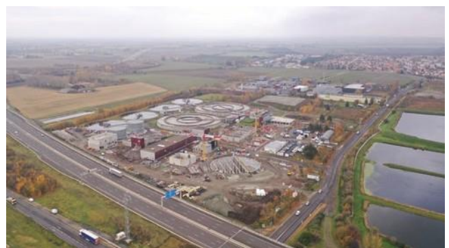
Travaux d'extension de la Station d'épuration des Trois Rivières
