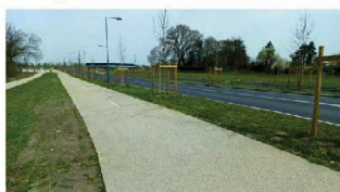
Chantier voie sud (mars 2022, SPL CA)
